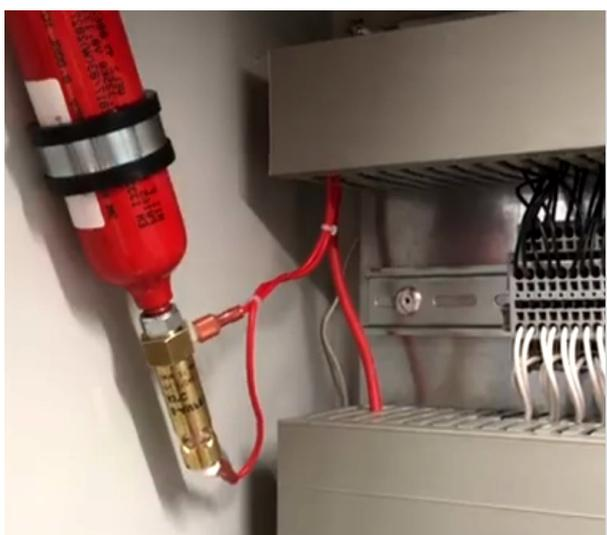
En raison de la **hausse de la chaleur** dans un scénario d'incendie, la pression à l'intérieur de l'ampoule de verre augmente.
